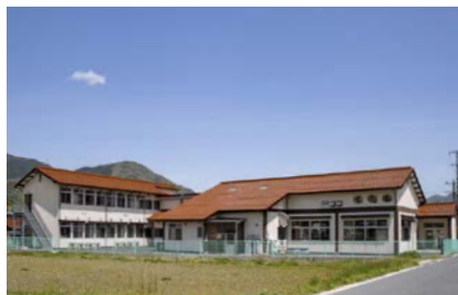
邑南町研修施設 邑学館 1室2人部屋 【男子生徒利用】 ※明溪寮に隣接
