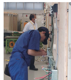
ものづくりコンテスト (電気工事)
